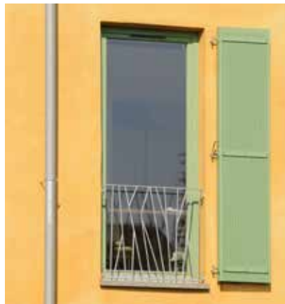
Durchgefärbt und ungestrichen ist der reine Kalkputz der Baugemeinschaft Zukunft
